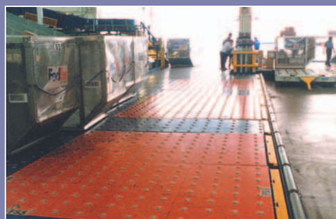
Оборудование аэродрома для манипуляции с алюминиевыми контейнерами AIR CARGO.
